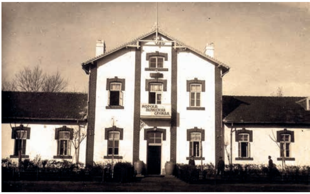
Сградата, в която след подписването на Ньойския договор (1919 г.) се помещава Щабът на Морската полицейска служба (официалното наименование на Черноморския флот), е построена специално за Морското училище. В нея то се помещава от 1913 до 1916 г.
